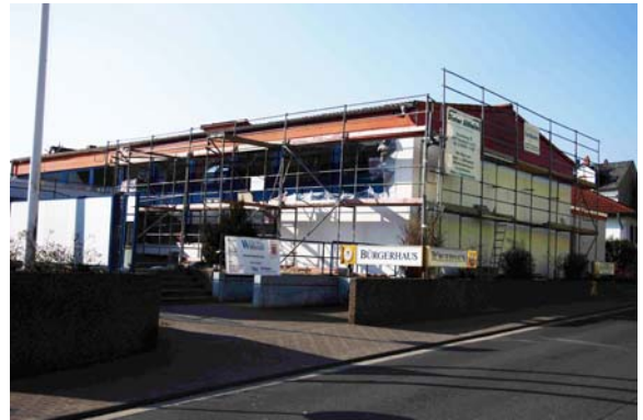
Sanierung und Modernisierung Bürgerhaus NW Kosten: 379.000.- Euro
