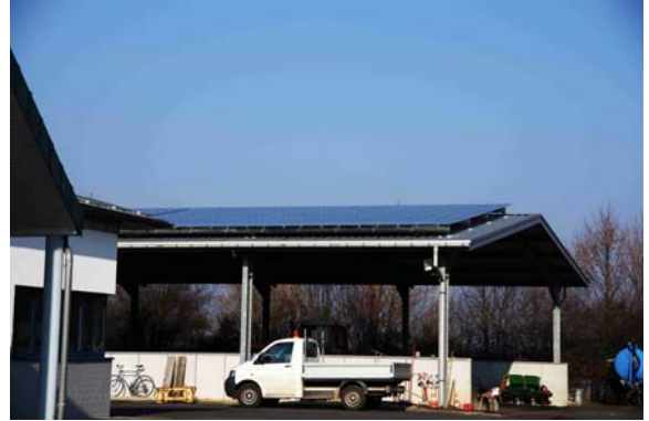
Bau Photovoltaikanlage Nieder-Wöllstadt Kosten: Über Abwasserverband finanziert.
