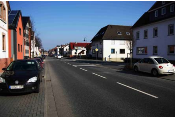
Totalsanierung B3 Nieder-Wöllstadt Kosten: 1.774.000.- Euro
