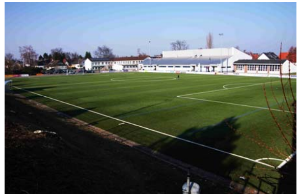
Sanierung Kunstrasenplatz Ober-Wöllstadt Kosten: 300.000.- Euro
