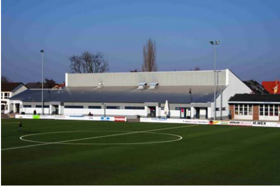
Sanierung und Modernisierung Römerhalle OW Kosten: 778.000.- Euro
