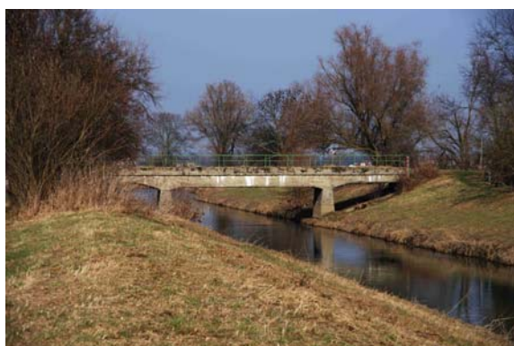
Neubau Fußgängerbrücke Niddaradweg Kosten: Übernahme durch Niddaradwegeverband
